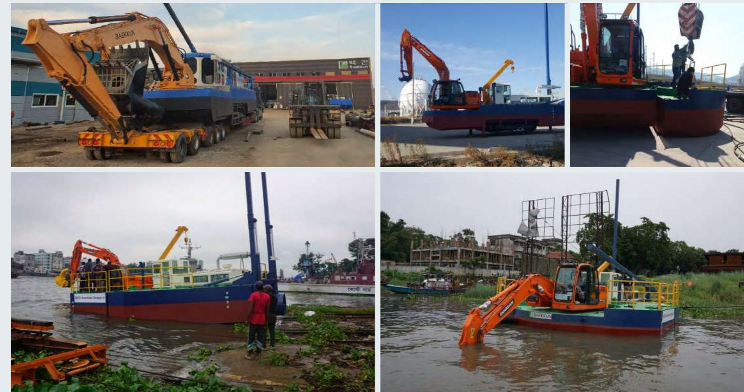
준설 작업 순서 | 운송 > 하차 > 조립 > 입수 > 준설
