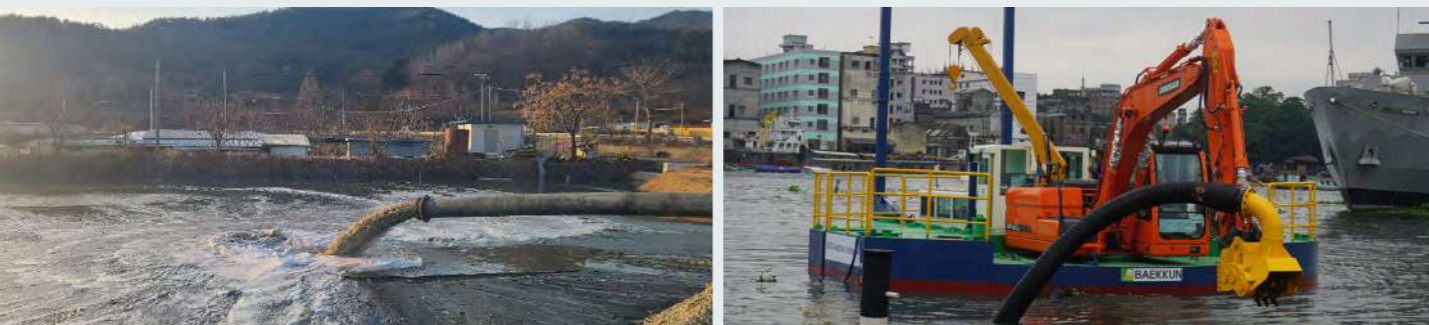
펌프 준설 | 자체 제작한 유압식 커터 사용
